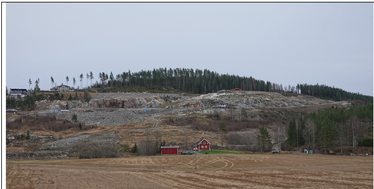
Bildet er tatt fra Villaveien og viser situasjonen i Festningsåsen 4 pr. 20.11.21.
