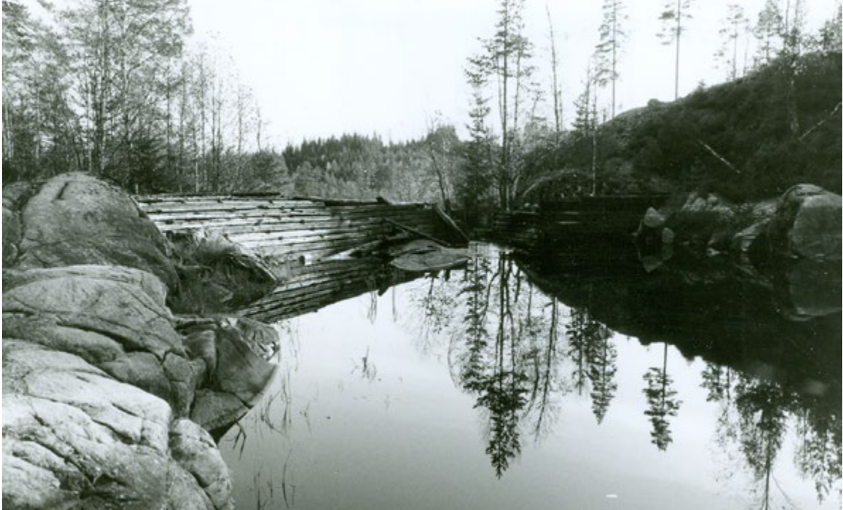
Røvassdammen og flere andre fløytedammer var dobbeltveggede laftedammer fylt med stein. De parallelle veggene var ca. en meter fra hverandre og ble holdt sammen av innlaftede stokker på tvers. Foto: Rømskog fotosamling.
