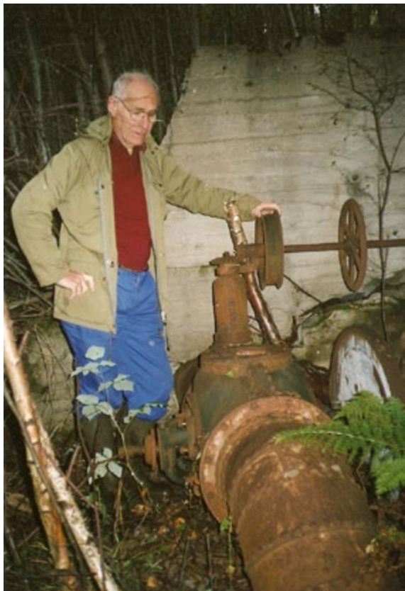
Jørgen Dahl ved den første kraftstasjonen på Rømskog. Hans bestefar Jørgen Jovall bygget denne i 1913 ved Trandemsætra. Den var i funksjon til flommen ødela dammen i 1918. Foto: Nils Nilssen, 1998.
