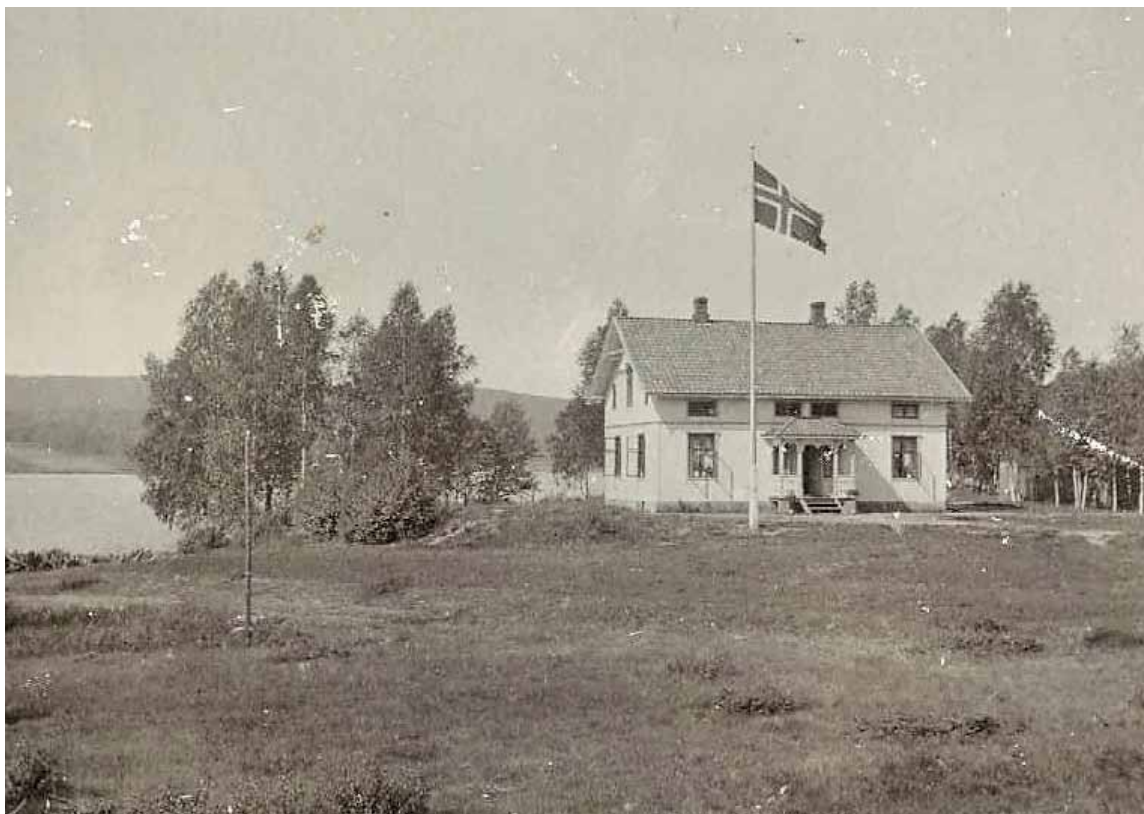
Rømskog kommunelokale fra 1909. Dette var det første byggeprosjektet etter at Rømskog ble egen kommune i 1902. Kommunelokalet ble plassert på en odde i nærheten av kirken. Huset ble brukt uendret fram til 1935 da det ble foretatt restaurering og et betydelig påbygg. Eier: Johs Ramberg.
