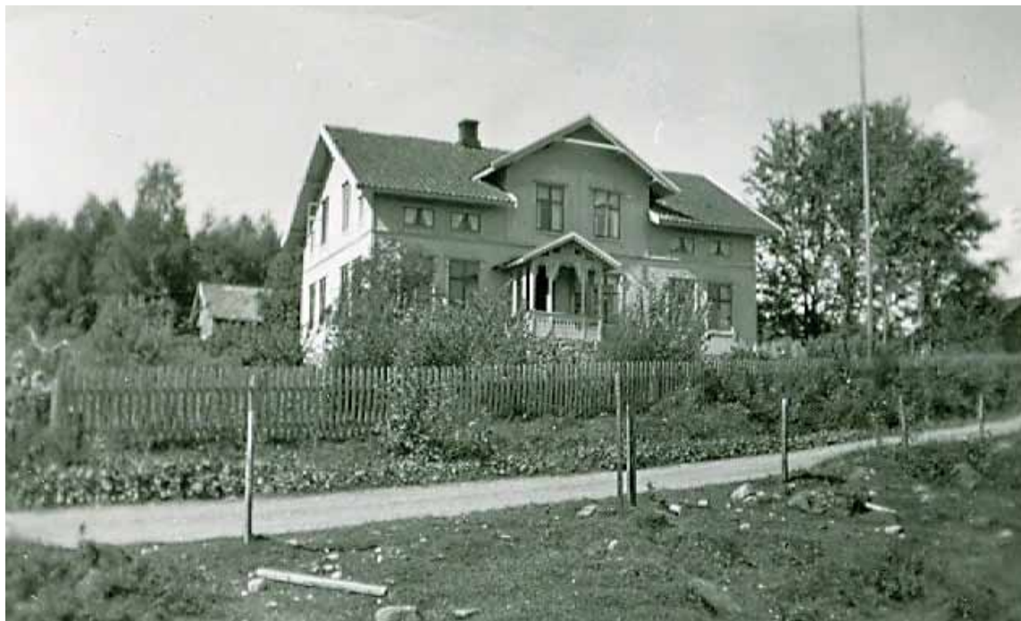
Skjønhaug var et sentralt hus på Vestsida. Her var det butikk i to perioder. De siste varene ble solgt straks etter krigen. I tillegg var det posthus fram til slutten av 1960-tallet, og telefonsentral fram til 1973. Eier: Rømskog lokalsamling.
