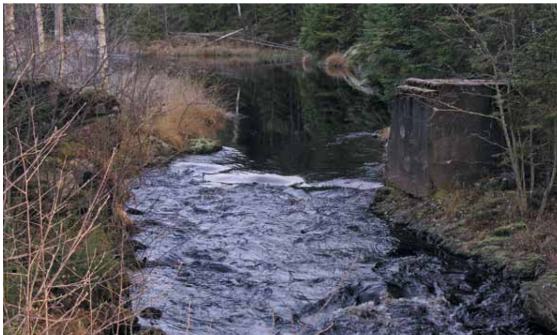
Dammene ved kraftstasjoner var viktige for å samle på vann og heve fallhøyden til turbinen. Her ses rester av dammen. Røret til turbinen er skjult til venstre. Foto: Finn Wahl, 2009.
