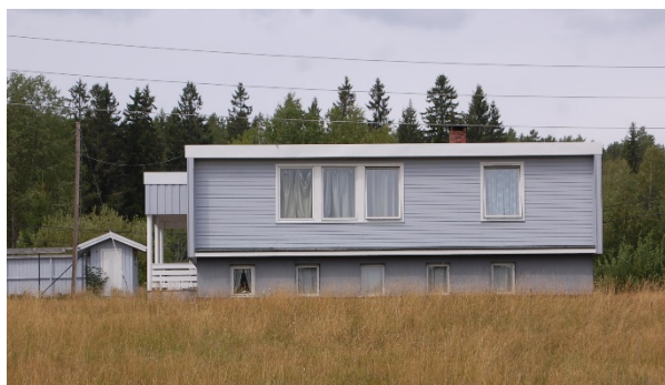
Modernistisk villa i Fosserveien 250.
