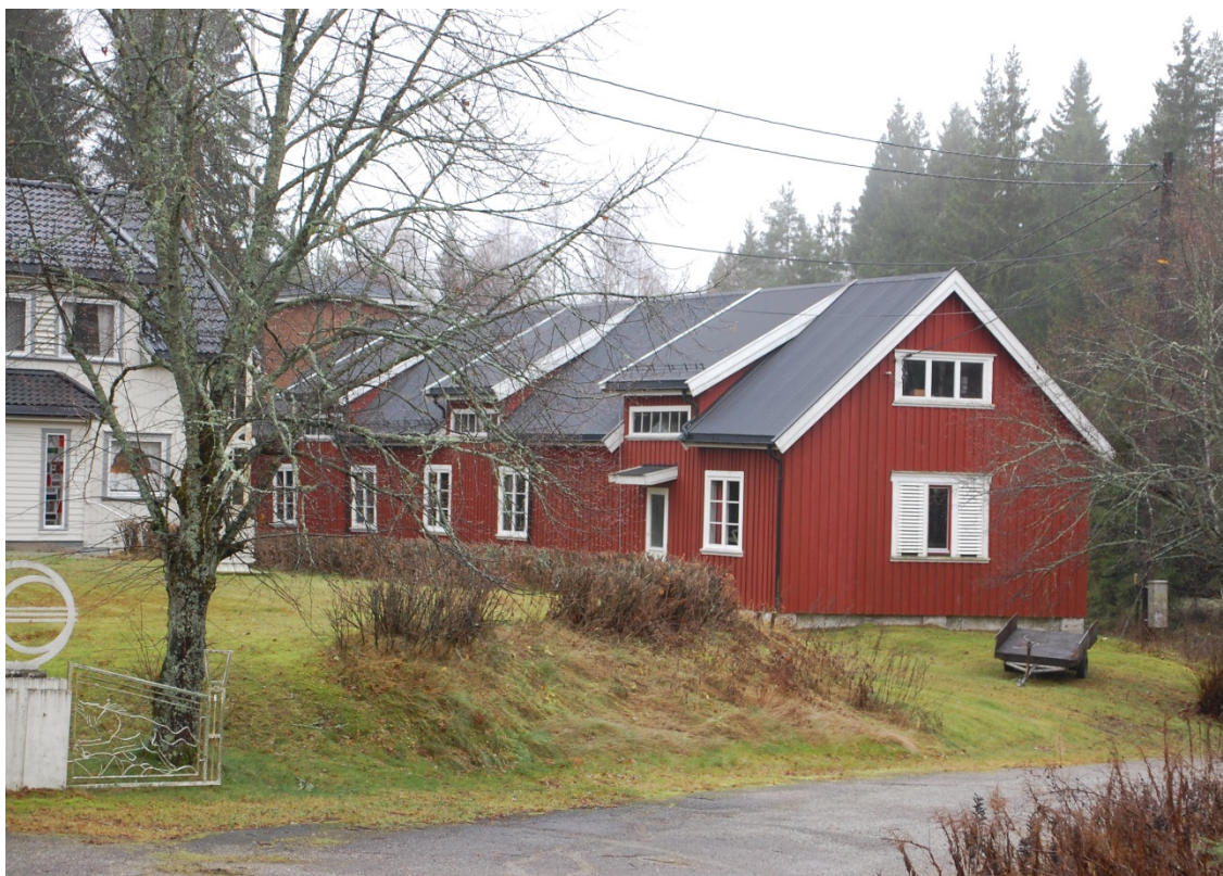
Forhenværende industribygg ved Skogheim.
