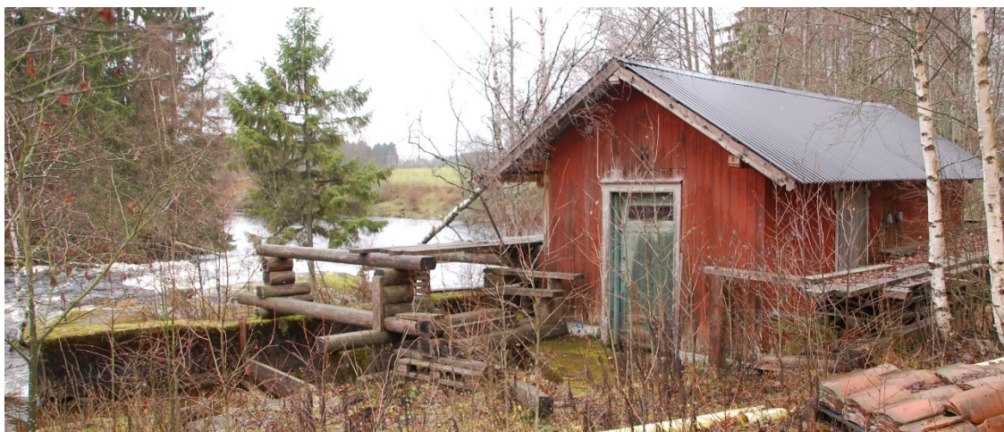
Den eldste kraftstasjonen ved Soprim.
