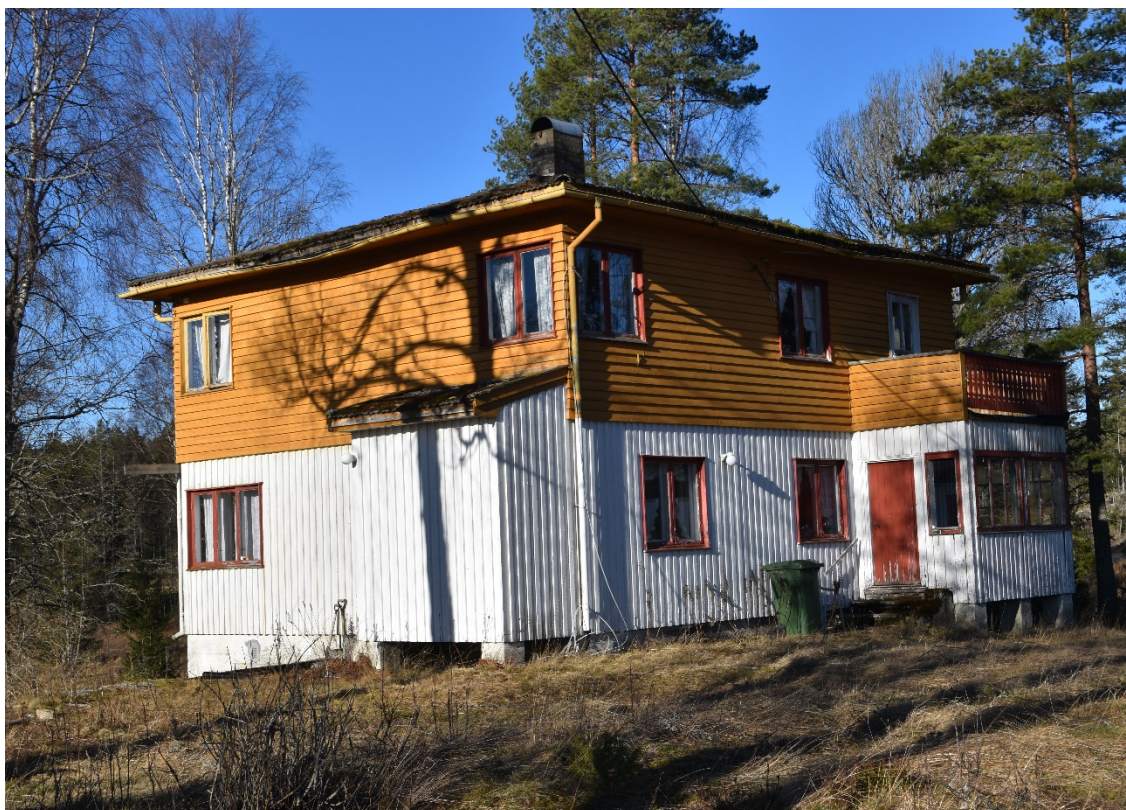
Skjeggensveien 342: Funkisvillaen med tilhørende garasje/uthus er svært lite endret, og fremstår som et av bygdas mest autentiske byggmesterfunkisanlegg.
