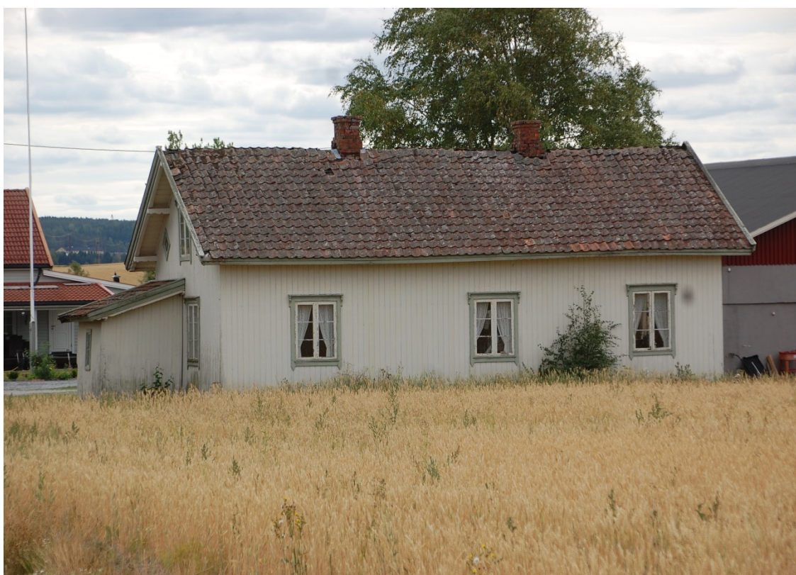
Gamlebygningen på Hol er godt bevart og ligger godt synlig fra Klapputveien.
