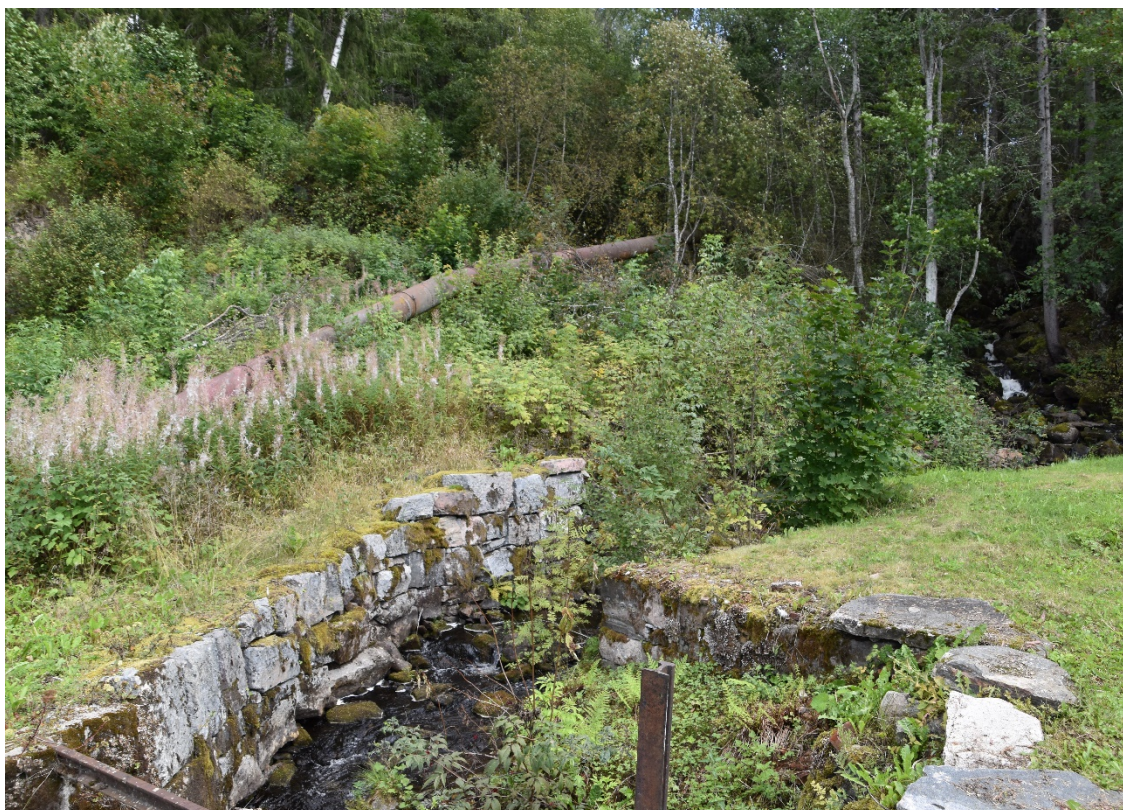
Forstøtningsmur og rørgate til kraftverket på Eidsverket.
