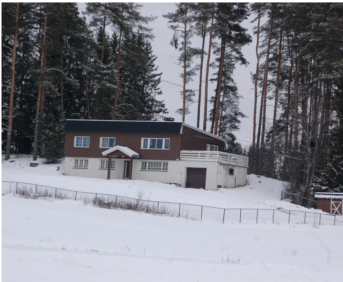
Nesveien 303 er et godt eksempel på etterkrigsmodernisme. Denne hustypen var spesielt populær på 1960-tallet.
