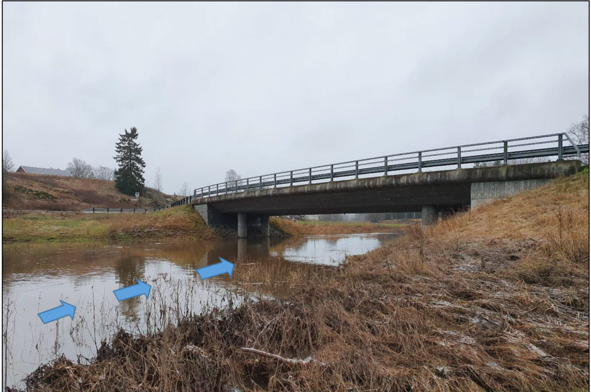
Figur 6: Bru Fv. 1460 over Hølandselva 500 m øst for planområdet.
