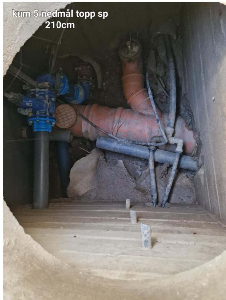
Figur 22: Bilder fra befaring 08. mai 2023. Eksisterende kum.
