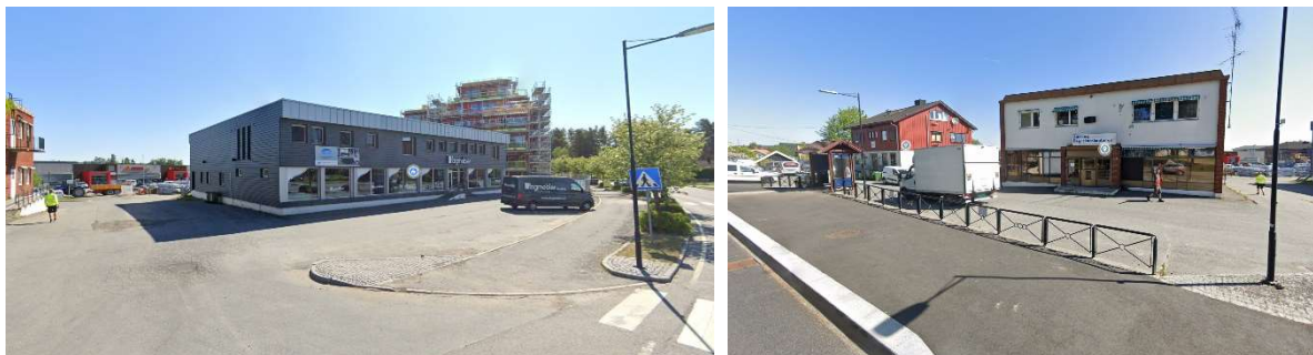
Bebyggelse i Aurveien 60-68 sett fra Aurveien. Mellom næringsbyggene går det en adkomstvei mellom Aurveien og Aurstubben (Google Street View).
