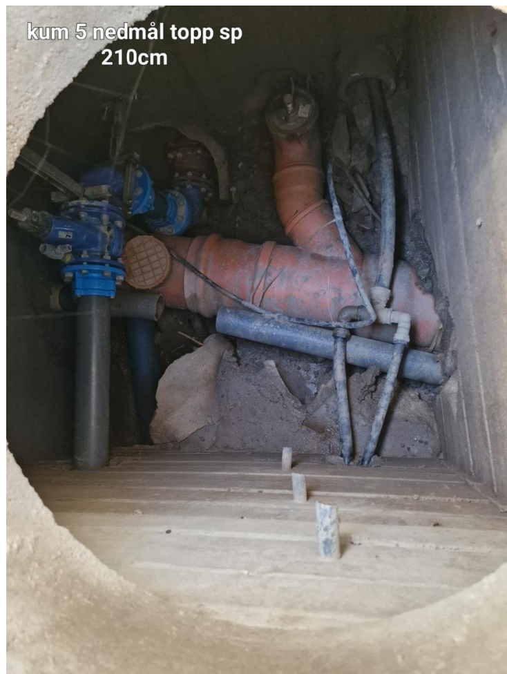
Figur 22: Bilder fra befaring 08. mai 2023. Eksisterende kum.
